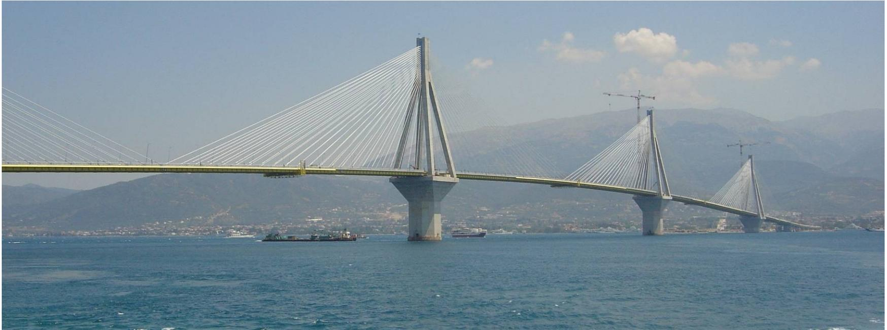
**Pont de Rion-Antirion, mis en service en 2004, d'une longueur totale de 2880 m, avec des portées de 286 m et 560 m.**
