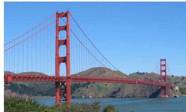
Le Golden Gate Bridge à San Francisco (États-Unis), commencé en 1917 et achevé en 1937. Il mesure 1970 m de long, la distance entre les deux tours principales étant de 1 280 m et leur hauteur est de 230 m au-dessus du niveau de l'eau.
