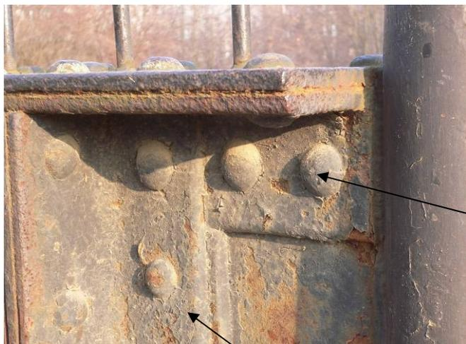
Ce mode d'assemblage s'avère long et cher. Une autre méthode est alors mise au point et en œuvre : l'assemblage par soudure.
